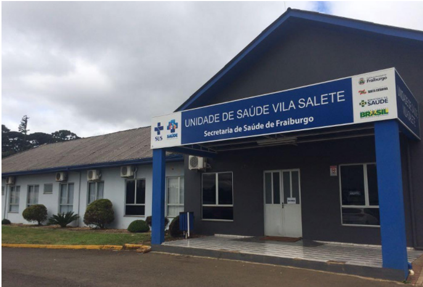
Imagem 22. Unidade de Saúde Vila Saete, em Fraiburgo-SC
